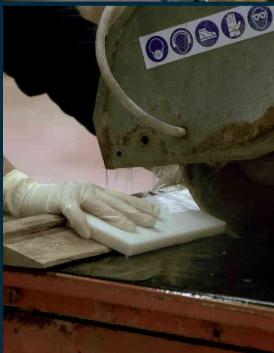
taglio con sega a disco ad acqua sawblade cut
